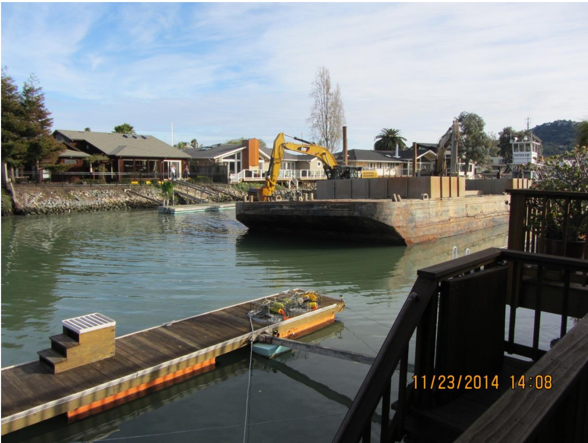
Dredger at Paradise Cay – CSA 29
