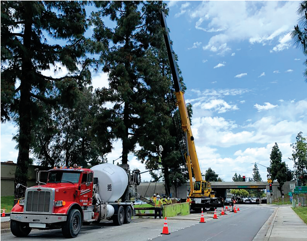
Las cuadrillas trabajan en la reubicación de servicios públicos como parte del proyecto de ampliación de la avenida Monte Vista.
