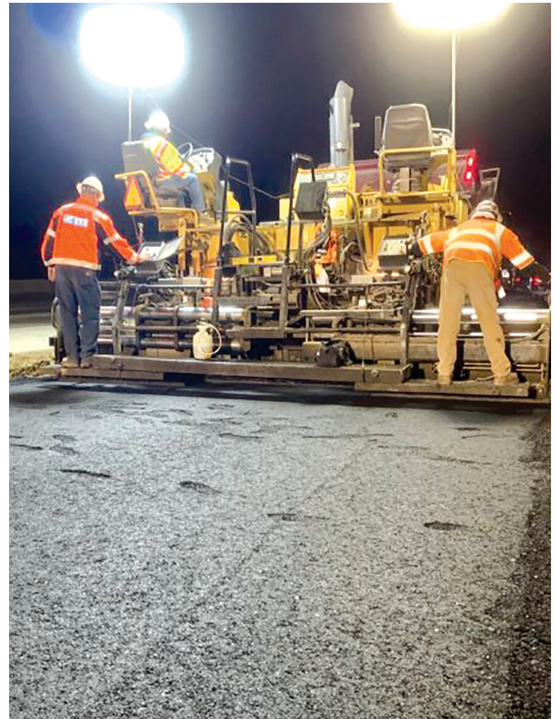
Equipos nocturnos pavimentando nuevos carriles a lo largo de la I-10.
