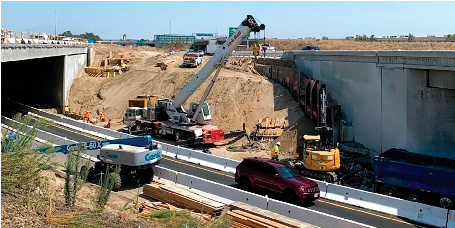
Se está construyendo el proyecto del corredor I-10. El proyecto agregará carriles expés en un tramo de 33 millas de la I-10, desde Montclair a Redlands.
