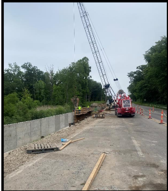
2 nd Segment of Retaining Wall Concrete Pour
