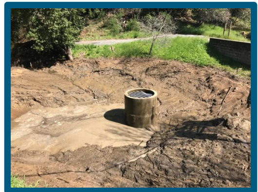
Las Casas drainage basin
