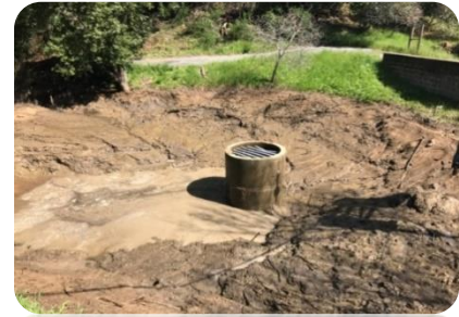
Las Casas drainage basin
