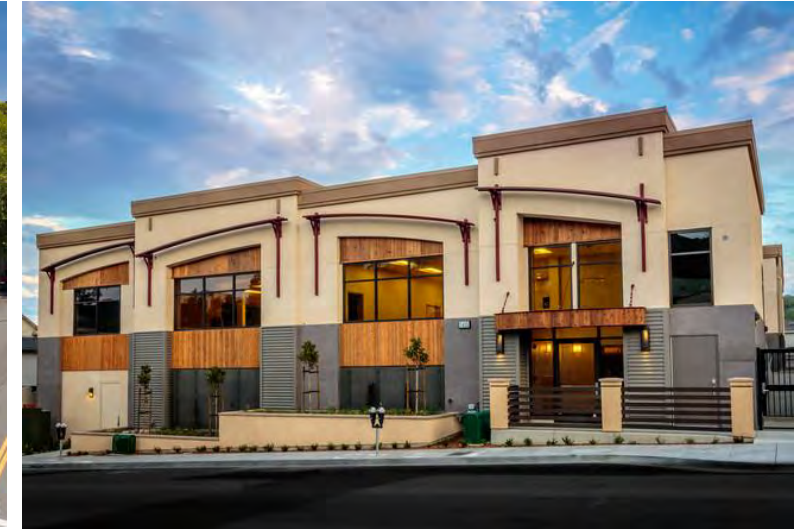
1415 3 rd St (built 2015)
