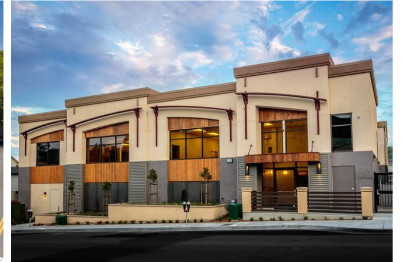
1415 3 rd St (built 2015)
