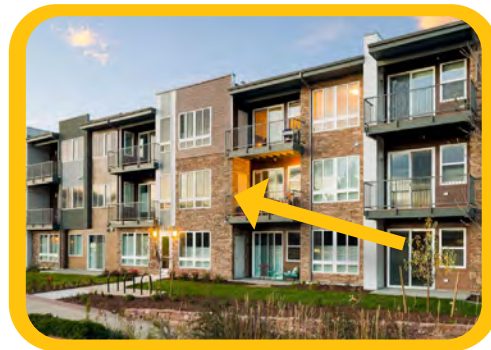
Chi Tiết Tòa Nhà
