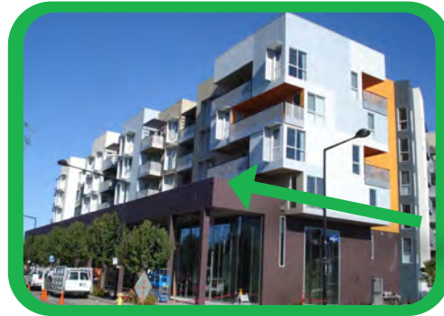
Lùi Tầng Tòa Nhà
