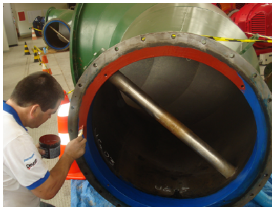
Boca de entrada de tubulação.
