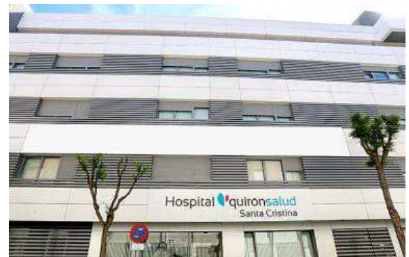
Fachada principal del Quirónsalud Santa Cristina. / H.Q.S.C.
