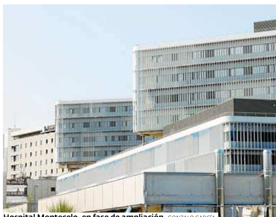
Hospital Montecelo, en fase de ampliación. GONZALO GARCÍA
