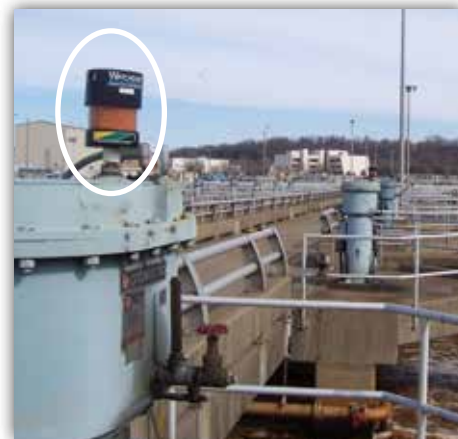
Respirador Watchdog® instalado en una caja de cambios en una facilidad de tratamiento de agua.
