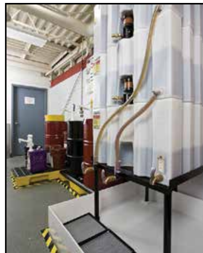
Sistema de Almacenamiento triple con tanques de 70 Galones, respiradores de desecante y bandeja de contención
