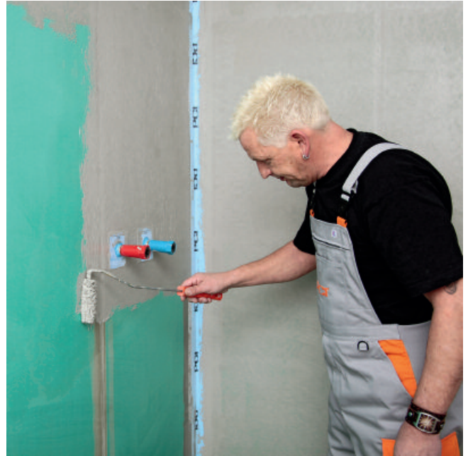
4. Erste Schutzschicht mit PCI Lastogum (grau) unverdünnt satt und oberflächendicht auf den Untergrundauftragen.
