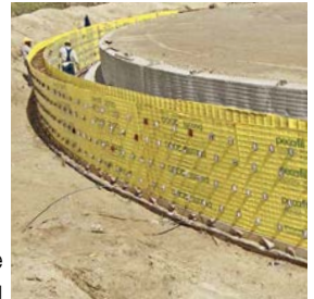
Gebogene Fundamentalschalung
