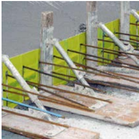
Freistehende wiederverwendbare Schalung
