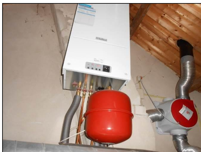
Foto 16: Zolder: CV-ketel (asbestvrij)
