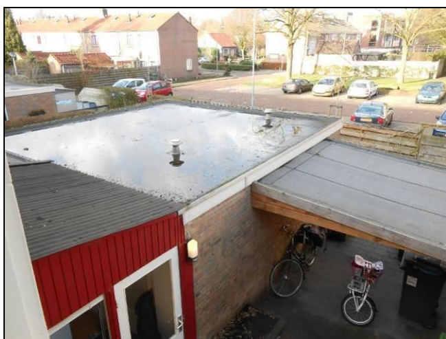
Foto 15: Achterzijde vanuit verdieping
