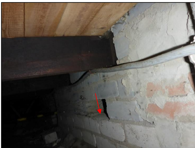
Foto 29: Kruipruimte: Vulplaatjes (Bron 2)
