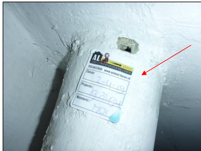
Foto 2: Zolder: Ventilatiebuis (Bron 1)
