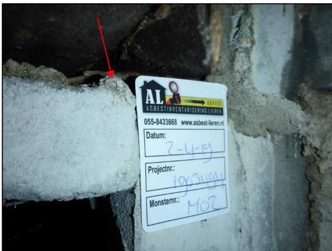
Foto 27: Kruipruimte: Vulplaatjes (Bron 2)
