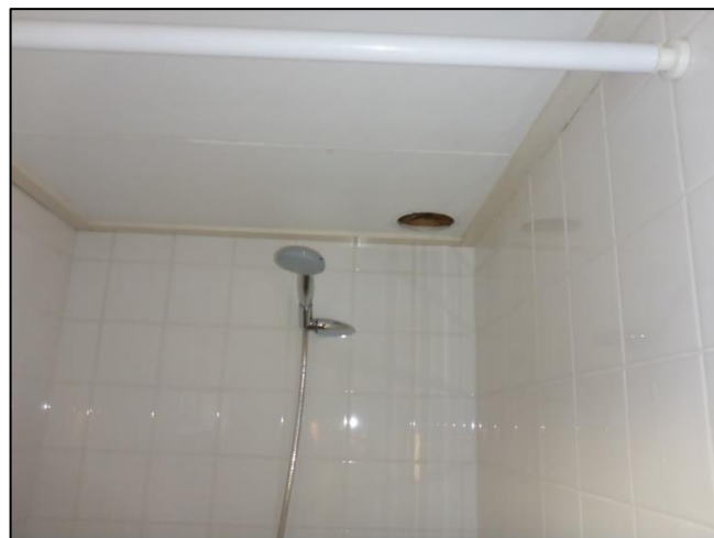
Foto 12: Badkamer: Ventilatiekanaal (Asbestvrij)
