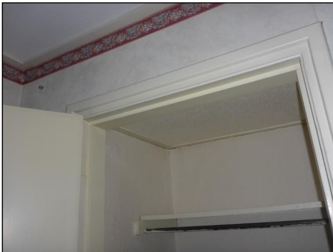
Foto 7: Slaapkamer: Beplating vaste kast (Asbestvrij)
