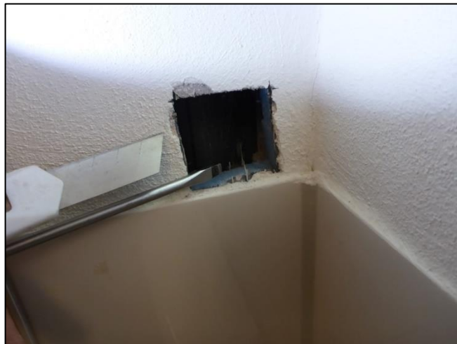
Foto 20: Toilet: Koof (Deconstructief onderzoek, asbestvrij)
