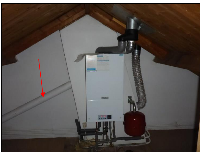
Foto 3: Zolder: Ventilatiebuis (Bron 1)
