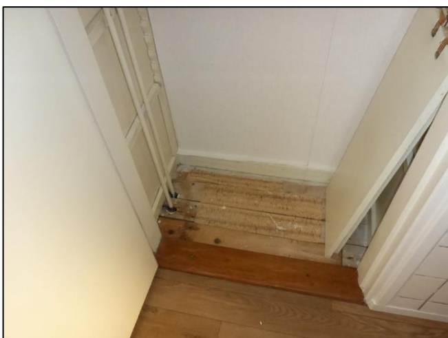
Foto 23: Toegang tot kruipruimte
