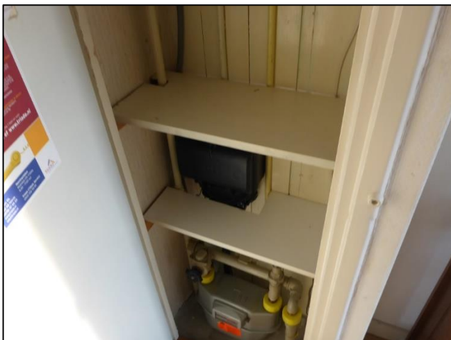
Foto 15: Hoofdzekeringskast (Ontoegankelijk)
