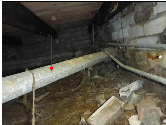
Foto 26: Kruipruimte: Afvoerbuis (Bron 5)
