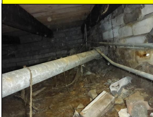
Kruipruimte: Afvoerbuis (Bron 5)
