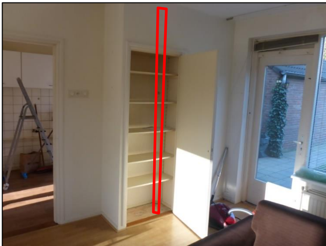
Foto 19: Woonkamer: Afvoerbuiskast (Bron 4)
