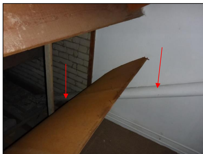
Foto 4: Zolder: Ventilatiebuis (Bron 1)
