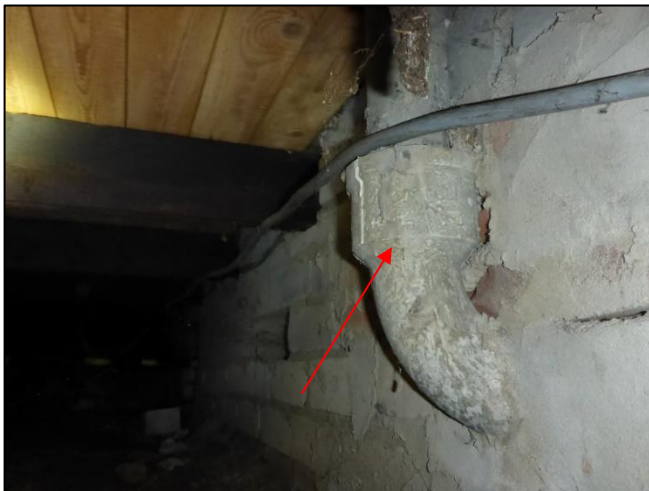
Foto 25: Kruipruimte: Afvoerbuis (Bron 5)
