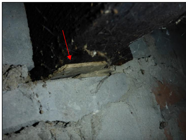
Foto 30: Kruipruimte: Vulplaatjes (Bron 2)
