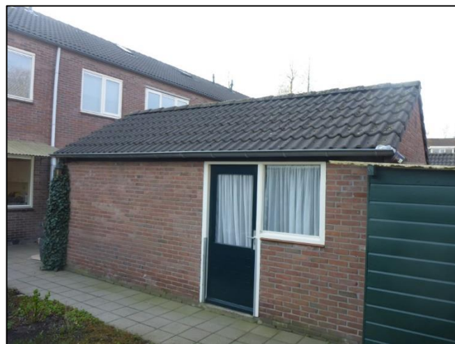
Foto 32: Berging: Raamkozijn (Asbestvrij)
