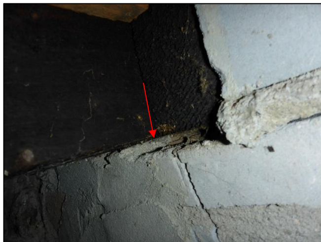
Foto 28: Kruipruimte: Vulplaatjes (Bron 2)
