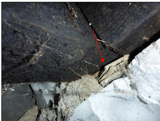
Foto 31: Kruipruimte: Vulplaatjes (Bron 2)
