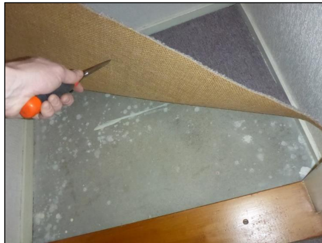
Foto 8: Slaapkamer: Onder vloerafwerking vaste kast (Asbestvrij)
