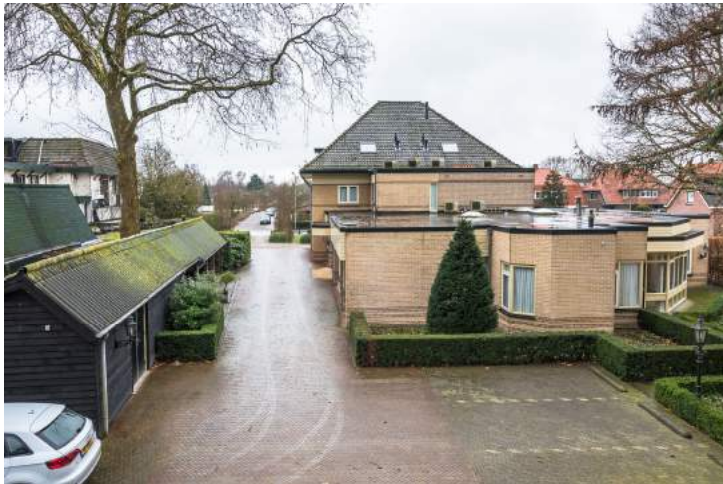
Veranda met separate archiefruimte. Archiefruimte is tevens uitgerust met alarm.
