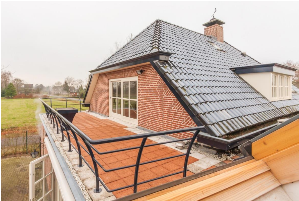
Het dakterras (24 m 2 ) is bereikbaar vanuit de eerste slaapkamer.
