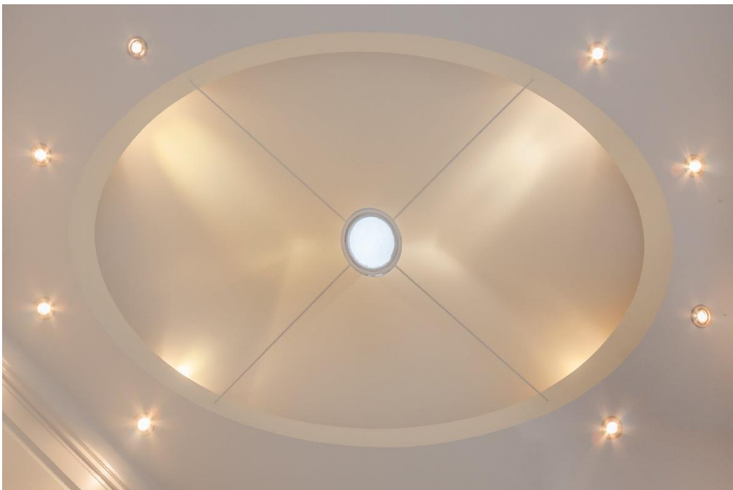
Sfeervolle plafond constructie met een Skytube en diverse inbouwspots.
