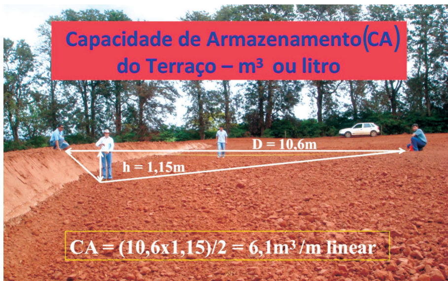
Foto 21 – Canal e camalhão de terraço, com representação esquemática mostrando as dimensões e o cálculo da capacidade de armazenamento de água.
