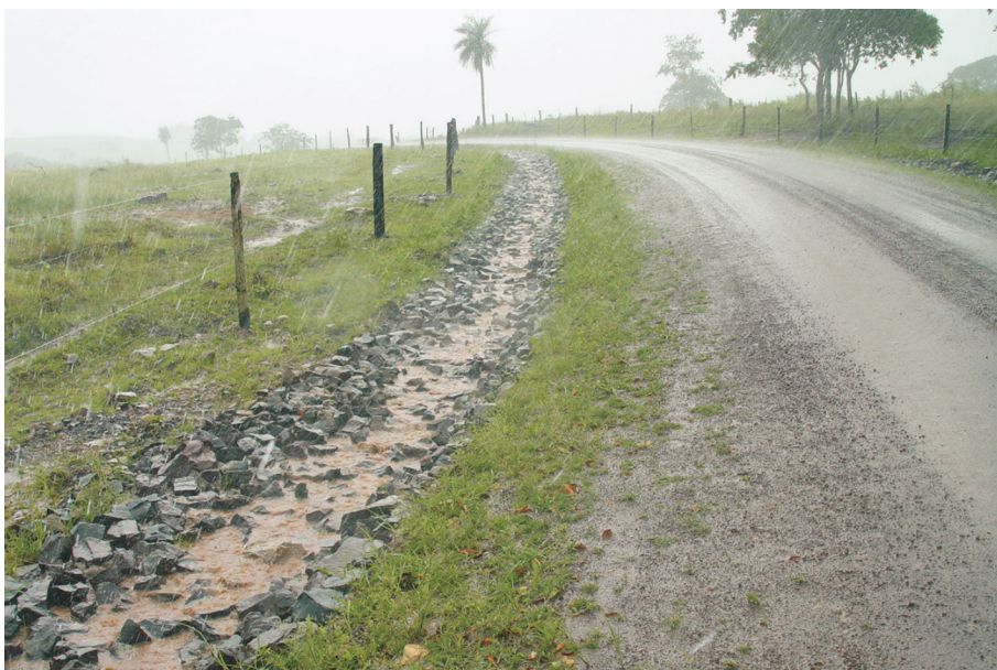
Foto 23 – Comportamento da água, por meio de uma alternativa simples de sistema de condução de águas em estrada rural devidamente projetada.
