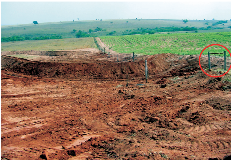
Foto 2 – Depois da implantação do Projeto de Recuperação de Voçoroca em Espírito Santo do Turvo (SP). Notar esticador de cerca como referência. Autor: Paulo Henrique Interliche – UTE Ourinhos/CATI.
