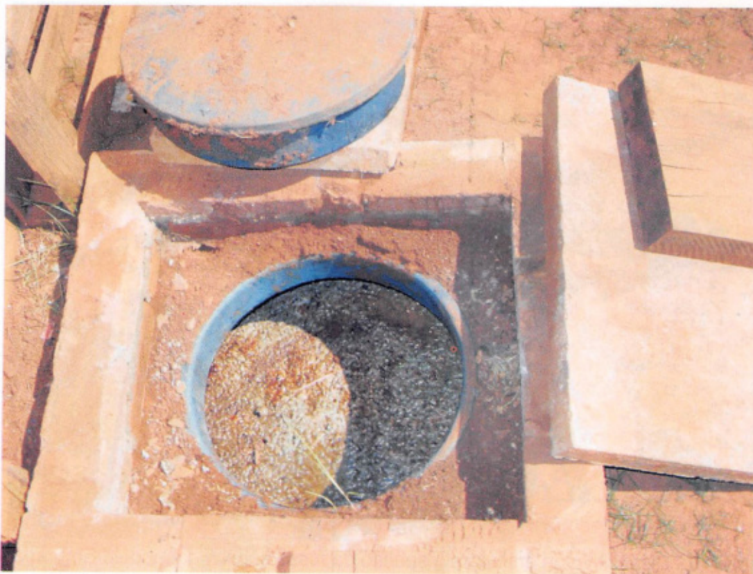
Figura 12 - Caixa para remoção de gordura quando o esgoto da cozinha também é tratado pela fossa séptica.
