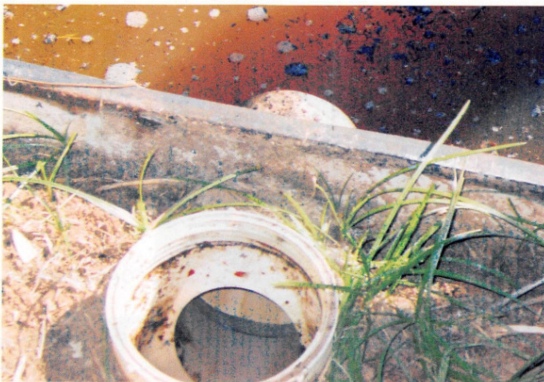
Figura 10 - Dispositivo de entrada e inspeção da fossa séptica do modelo Embrapa.
