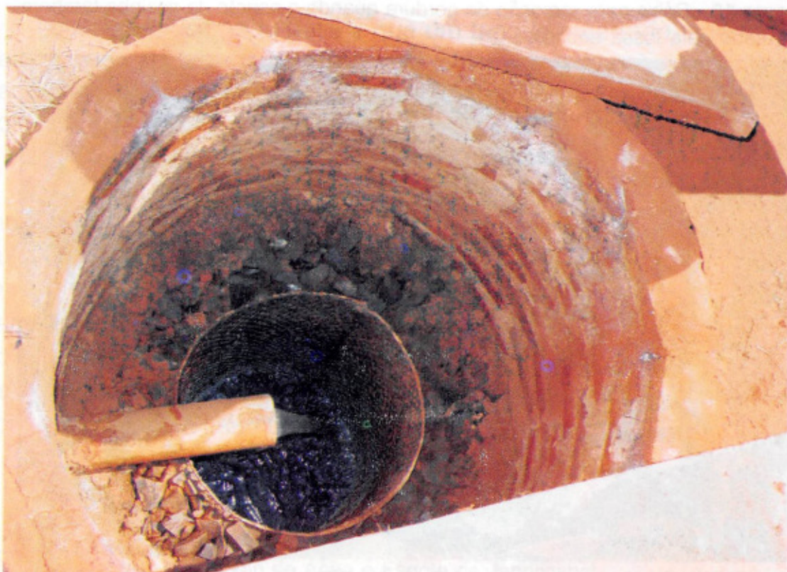
Figura 11 - Vista superior de um sumidouro em funcionamento.
