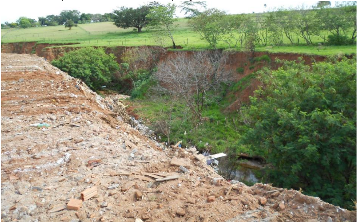
Foto 27 - Voçoroca situada em área periurbana.
