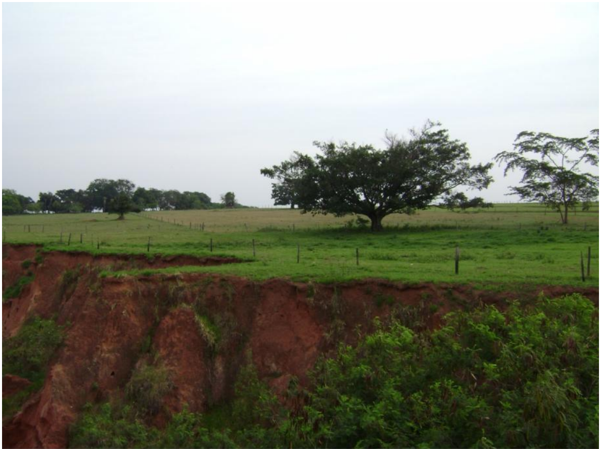
Foto 4 - Erosão no talude do córrego afluente do rio Afonso XIII.
