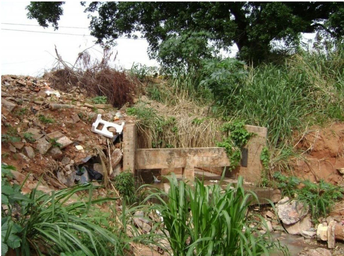
Foto 6- Deposição de resíduos da construção civil na margem de estrada Sem Sigla-8.
