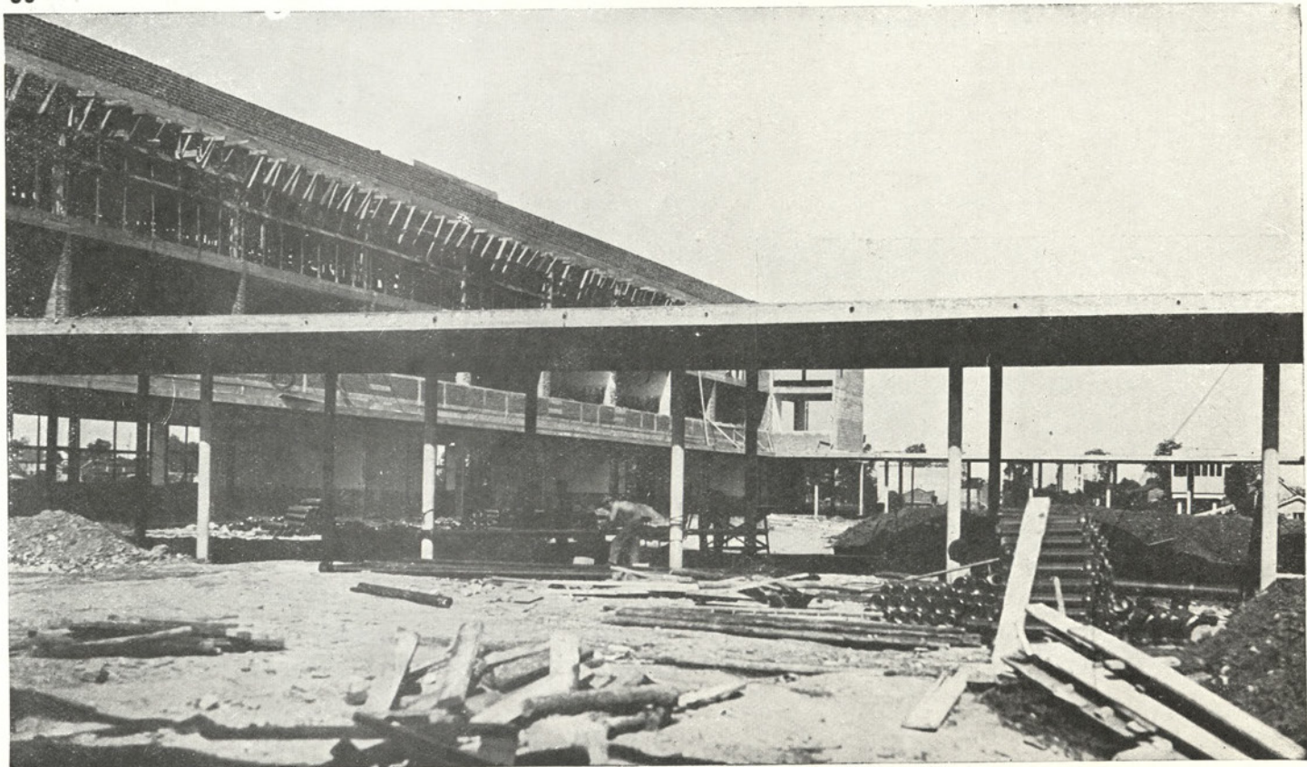
FAÇADE SUD 15 JUIN 1932
