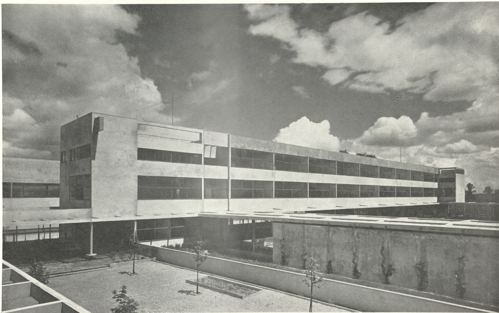
VUE D'ENSEMBLE DU BATIMENT DES ECOLES - COTE SUD
