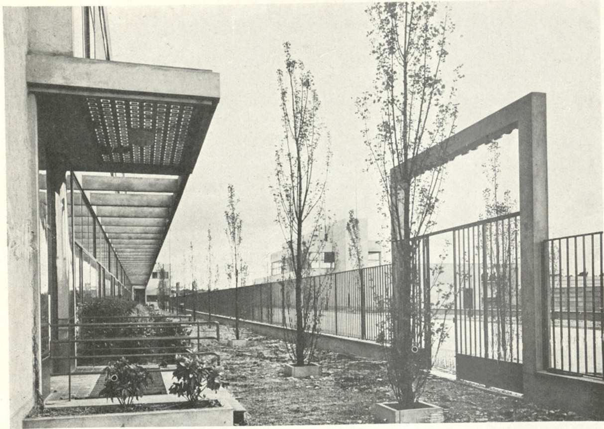
98. ENTREE DE L'ECOLE DE GARÇONS DANS LE FOND: LE GYMNASE
