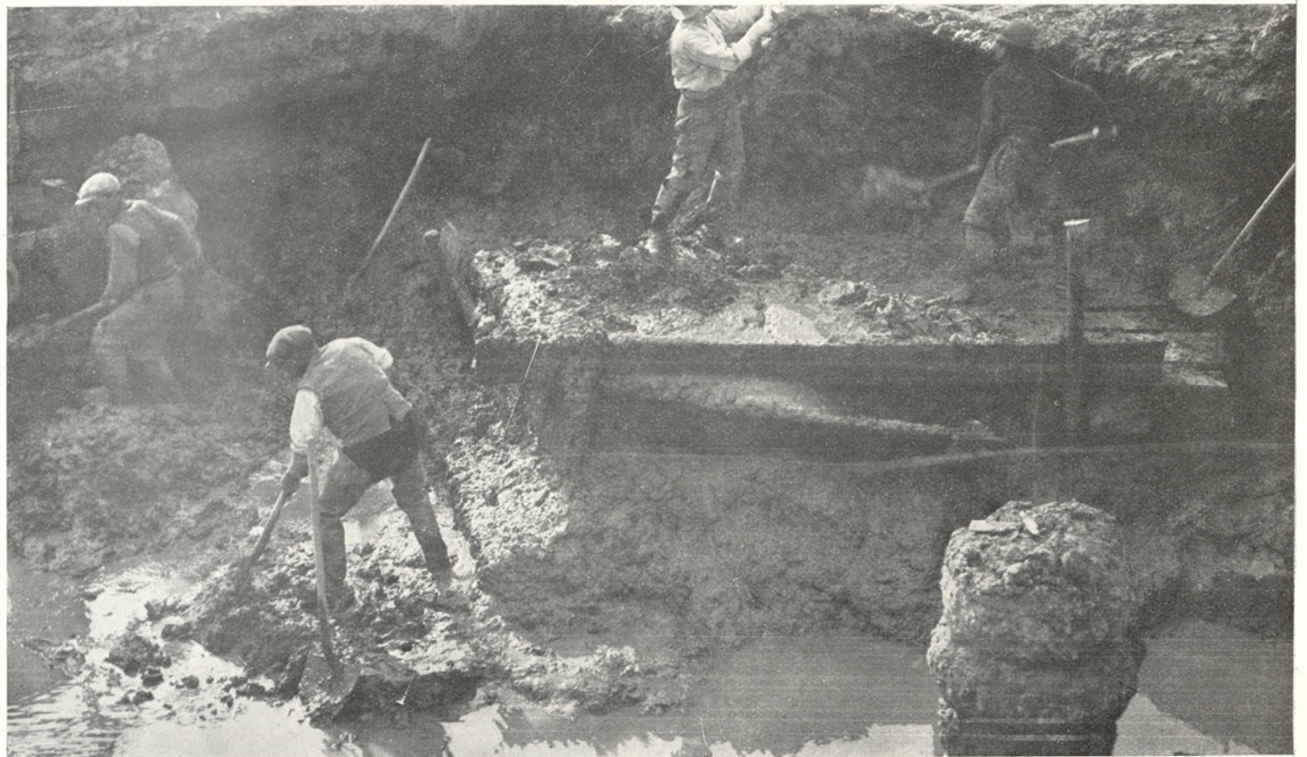
LA FOUILLE DE LA SALLE DE CHAUFFE - TROIS SOURCES FURENT CAPTEES A CET EMPLACEMENT, ET DEVIEES VERS L'EGOUT PAR LES CANALISATIONS MAITRESSES DU DRAINAGE
