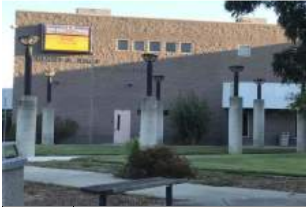
#85 SITE POLE LIGHT
