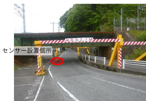
図 19. パターン2・道路最低面のピット内に水位センサーが設置されている例（興津東）
