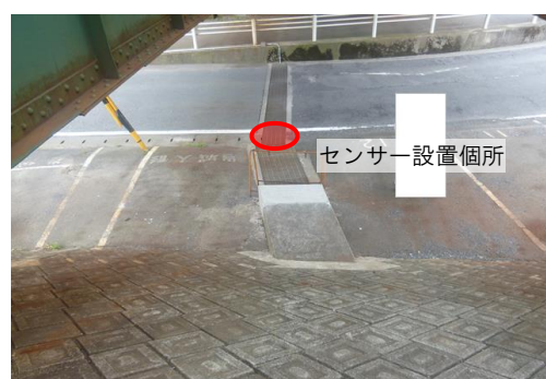
図 19. パターン2・道路最低面のピット内に水位センサーが設置されている例（興津東）
