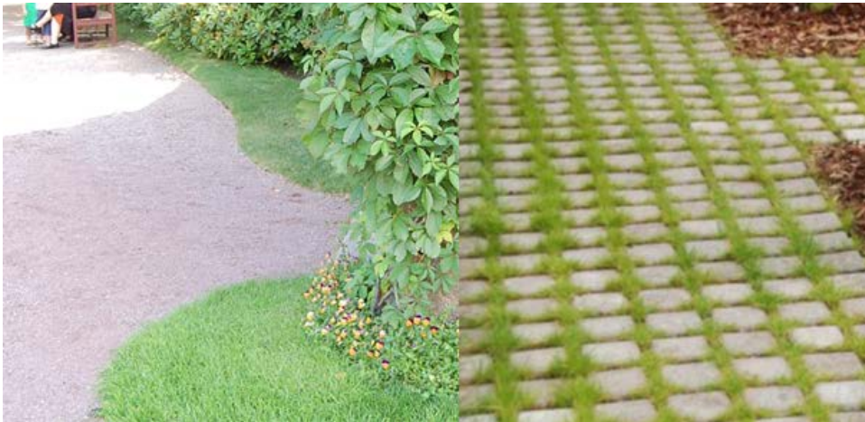
Kuva 2 Esimerkkejä vettä läpäisevistä pinnoitteista. (Vasemmanpuoleinen kuva Hvitträsk, oikeanpuoleinen kuva Tampere, Vuores, FCG)
