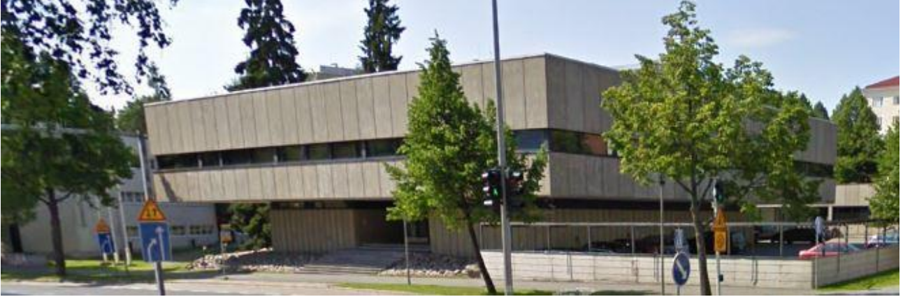
Itä-Suomen hovioikeus edustaa linjakasta betoniarkkitehtuuria.
