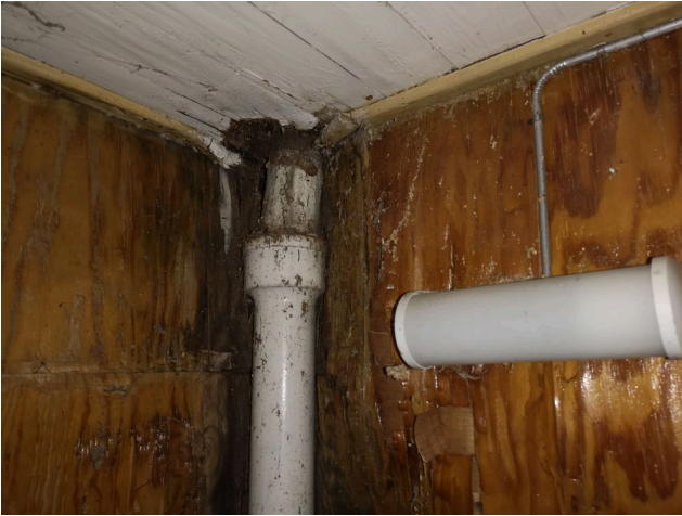
Kuva 11. Lahovaurioita seinissä ja välipohjassa
