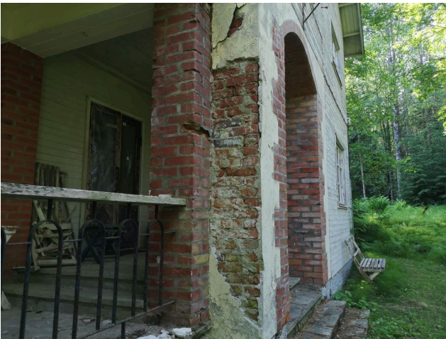
Kuva 13. Pilari rapautunut
