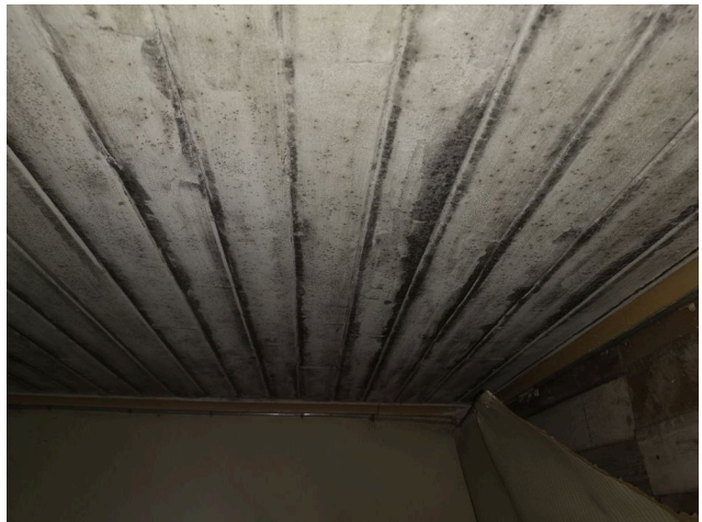
Kuva 20. Pintamikrobikasvustoa alakatossa
