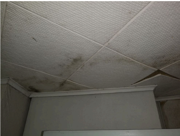
Kuva 21. Vuotojälkiä ja pintamikrobikasvustoa
