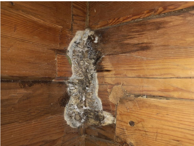
Kuva 19. Lahottajasienikasvustoa hirsien liitoksessa
