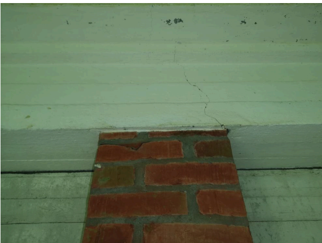
Kuva 15. Betonipalkissa halkeama
