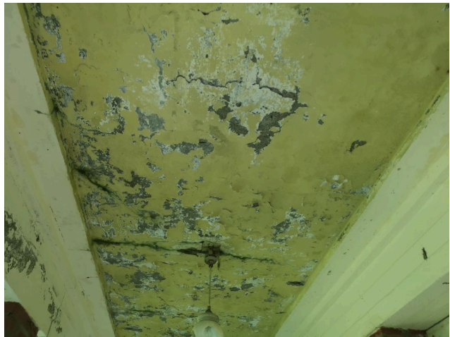
Kuva 14. Parvekelaatta rapautunut, laatasta halkeamia
