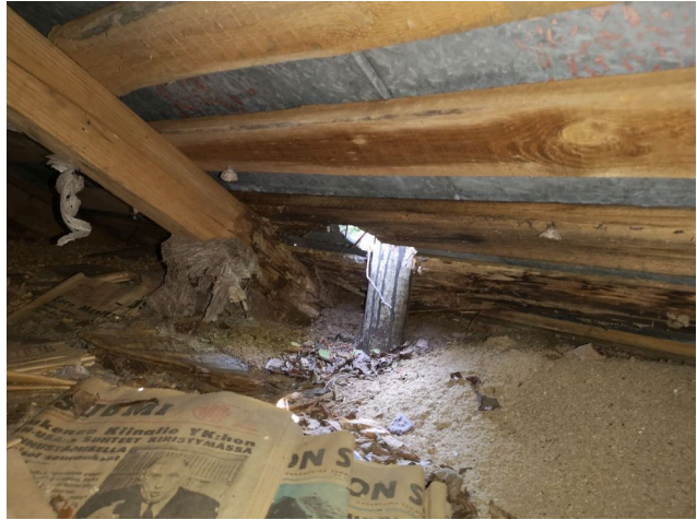
Kuva 12. Kattokannattajassa ja ruodelaudoissa lahoa
