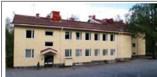
Kuva 10 Metsäkoulun vanha päärakennus
