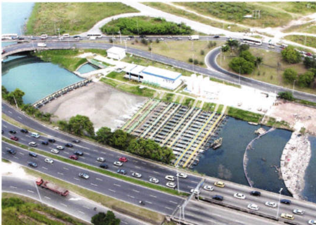
UTR do Rio Arroio Fundo - Despoluição das Lagoas de Jacarepaguá - RJ.
