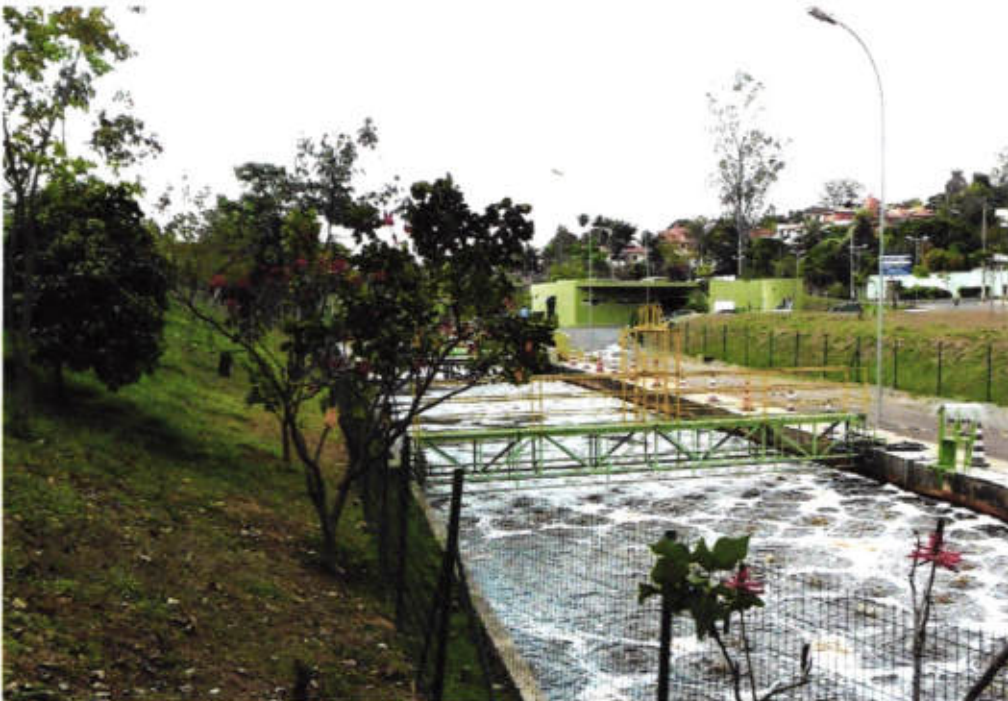
UTR do Córrego Ressaca/Sarandi - Despoluição da Lagoa da Pampulha - MG.
