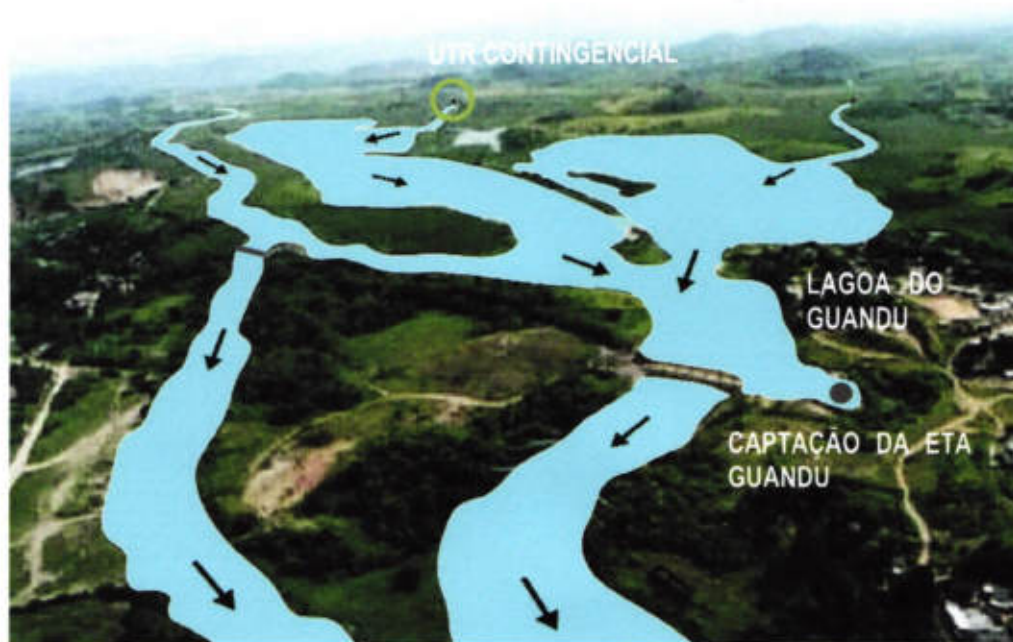
Imagem aérea do principal rio contribuinte da Lagoa do Guandu e localização geral da UTR Contingencial FLOTFLUX®
