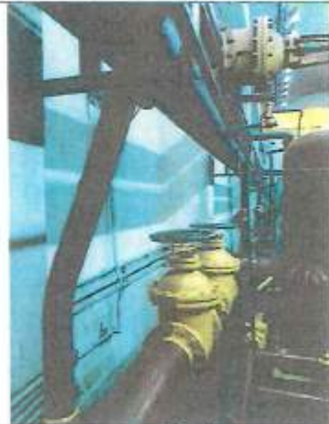
Figura 04 – Trecho com dificuldades para pintura.
