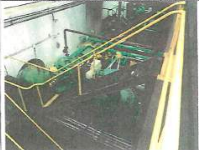
Figura 02 - Empoçamento de água. Informe que o piso em questão terá caimento para o ralo de drenagem.
