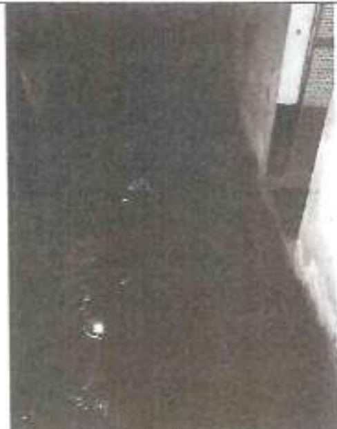
Figura 02 - Empoçamento de água. Informe que o piso em questão terá caimento para o ralo de drenagem.
