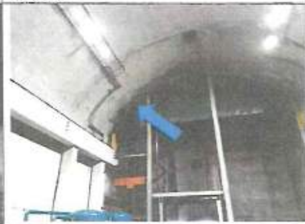
Figura 04 – Imagem do teto do poço de bombas.
