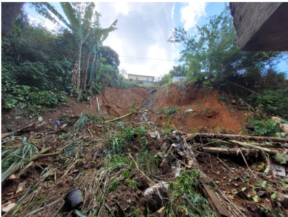
Figura 5: Vista frontal da ruptura
