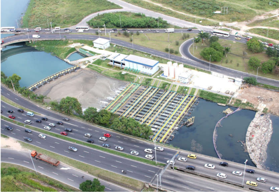
UTR do Rio Arroio Fundo - Depoluição das Lagoas de Jacarepaguá - RJ.
