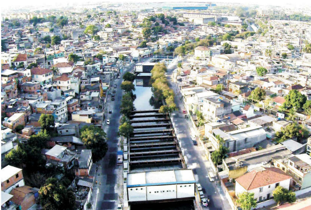
UTR do Rio Irajá - Despoluição da Baía de Guanabara - RJ.
