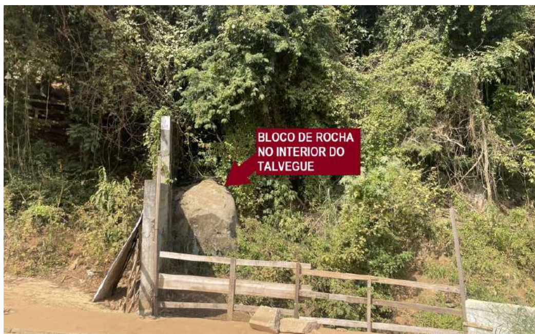
Foto 4 – Área 2: bloco de rocha observado no interior do talvegue
