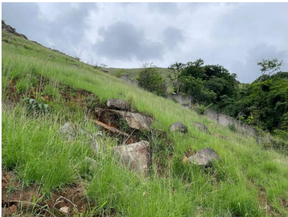
Figura 38- Detalhe dos blocos de rocha no talude
