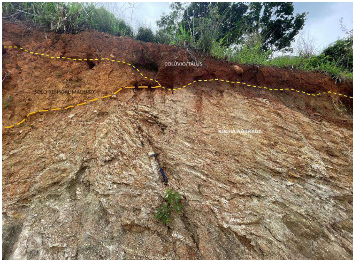
Figura 14- Perfil de intemperismo típico da região, observado na base das contenções existentes.
