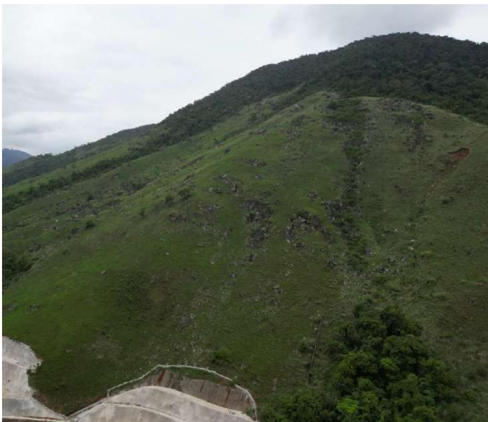
Figura 39- Detalhe dos blocos de rocha no talude
