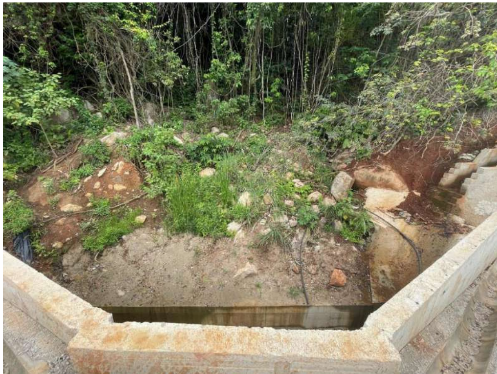
Figura 22- Estrutura de retardo construída recentemente com muitos blocos aparentes.
