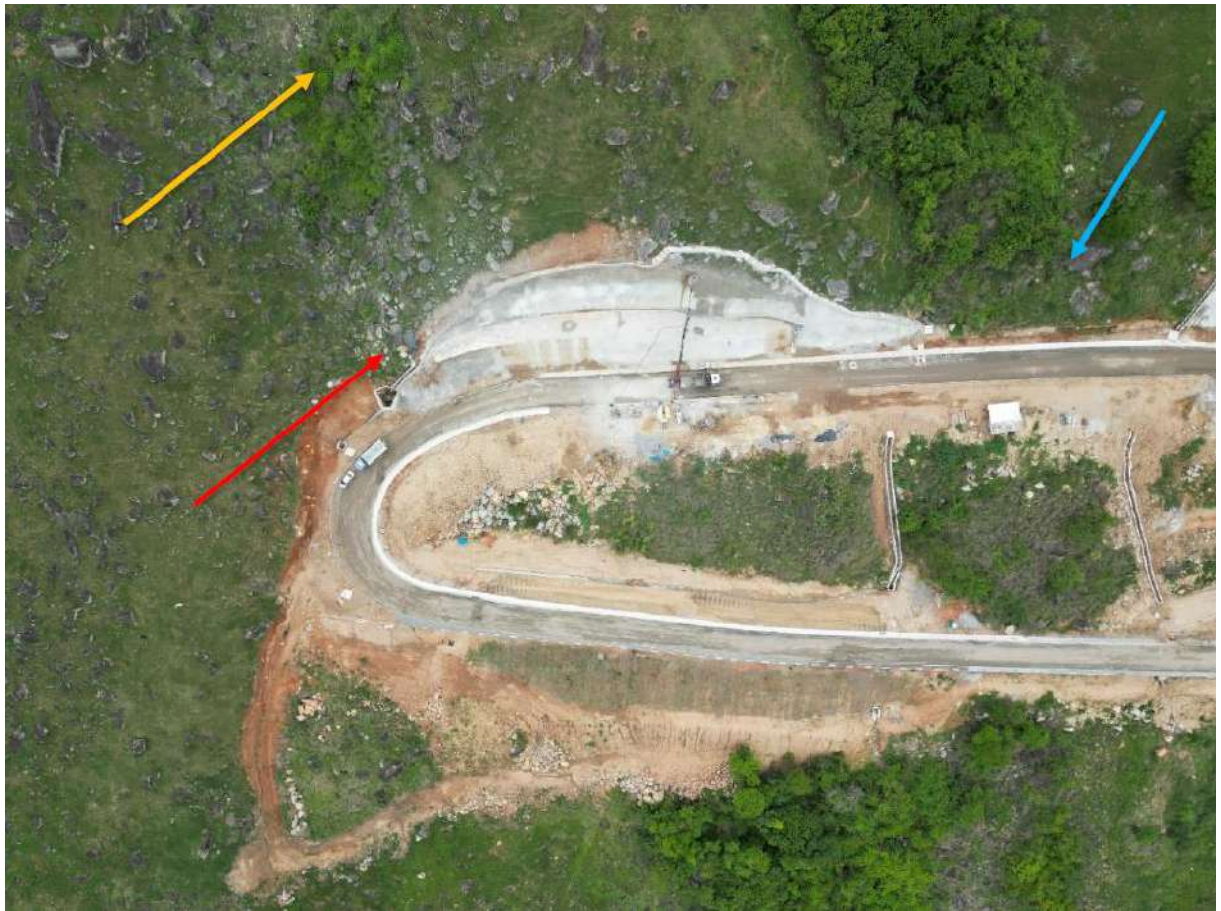
Figura 51- Aspectos da área 4: A seta azul com depósito de tálus encaixado na drenagem. Na seta amarela um ninho de blocos in situ, em afloramento fraturado e em vermelho o depósito de tálus, a jusante.
