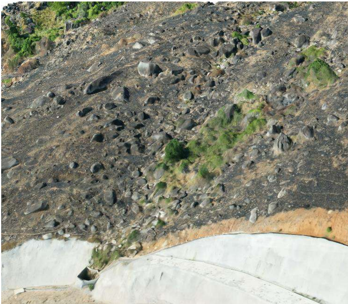
Foto 16 – Área 4: diferentes pontos de concentração de blocos observados na região de montante
