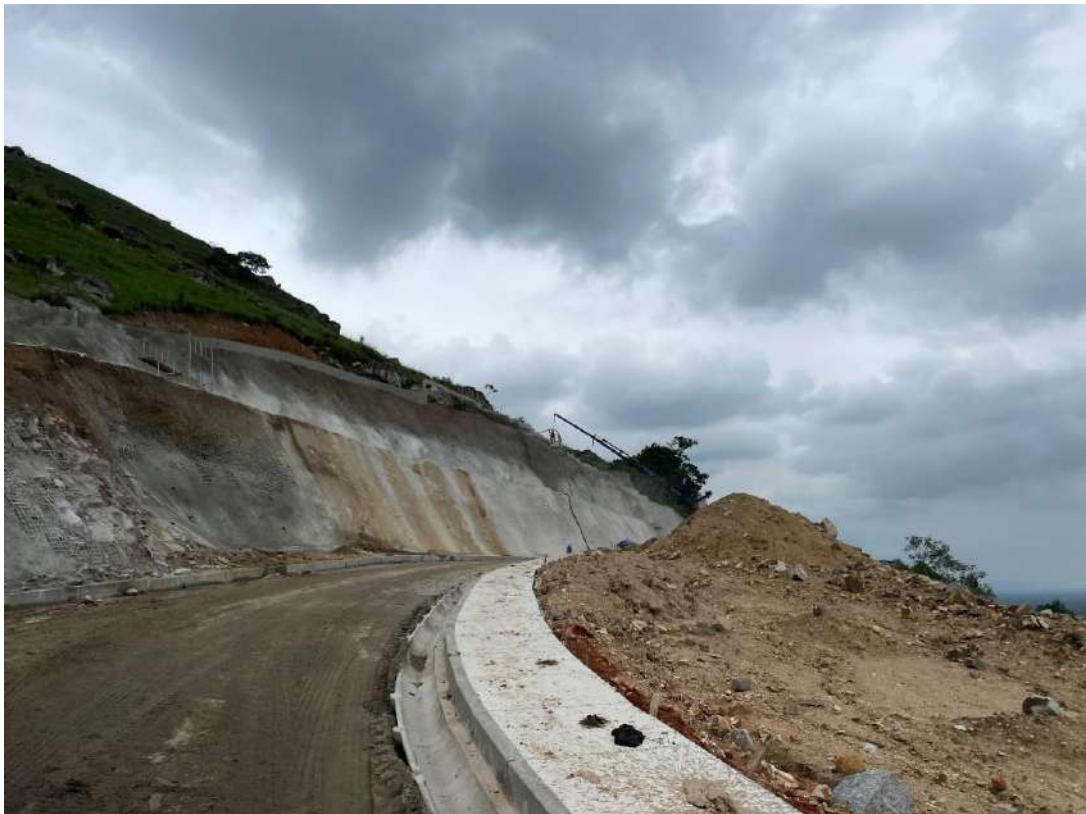
Figura 49- Detalhe do trecho.
