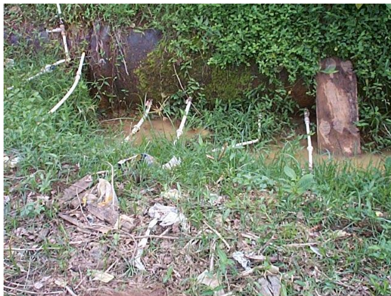
FLAGRANTE DE LIGAÇÕES CLANDESTINAS EM ADUTORA
