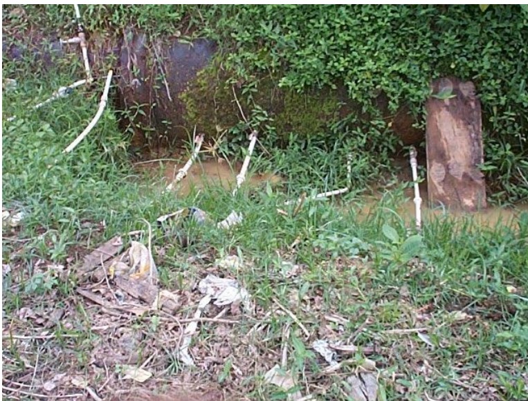
FLAGRANTE DE LIGAÇÕES CLANDESTINAS EM ADUTORA
