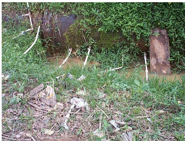
FLAGRANTE DE LIGAÇÕES CLANDESTINAS EM ADUTORA
