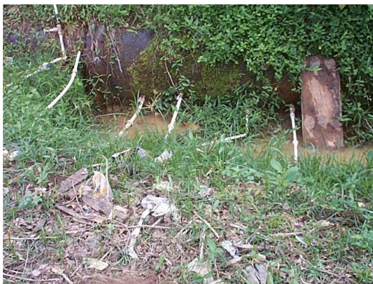
FLAGRANTE DE LIGAÇÕES CLANDESTINAS EM ADUTORA
