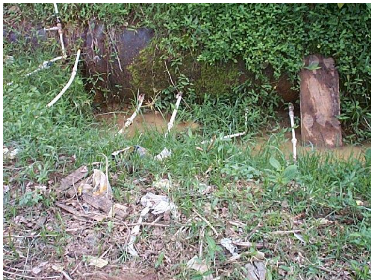
FLAGRANTE DE LIGAÇÕES CLANDESTINAS EM ADUTORA
