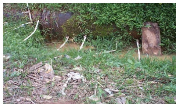
Flagrante de ligações clandestinas em adutora
