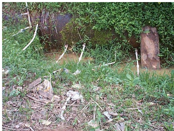
FLAGRANTE DE LIGAÇÕES CLANDESTINAS EM ADUTORA
