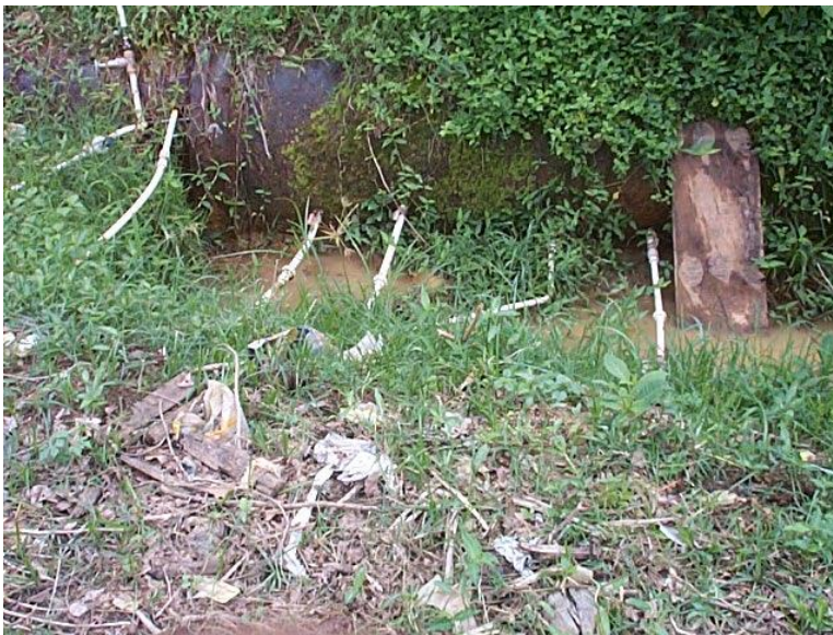
FLAGRANTE DE LIGAÇÕES CLANDESTINAS EM ADUTORA
