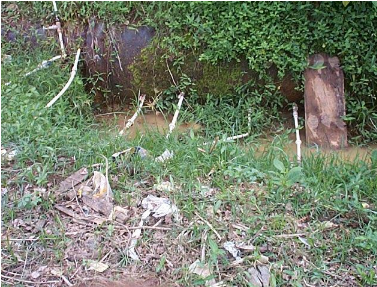
FLAGRANTE DE LIGAÇÕES CLANDESTINAS EM ADUTORA
