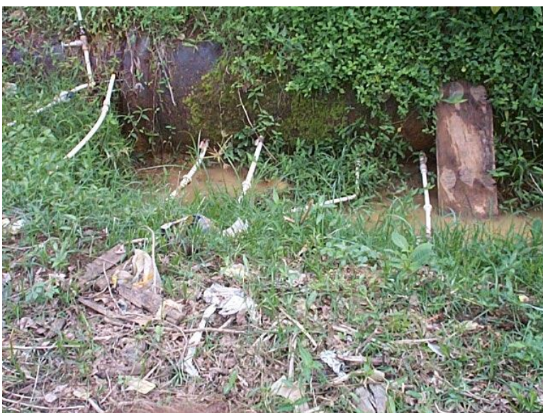
FLAGRANTE DE LIGAÇÕES CLANDESTINAS EM ADUTORA
