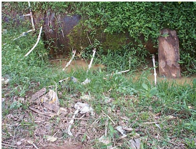
FLAGRANTE DE LIGAÇÕES CLANDESTINAS EM ADUTORA
