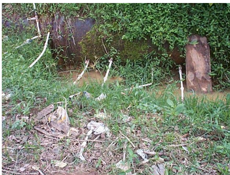
FLAGRANTE DE LIGAÇÕES CLANDESTINAS EM ADUTORA
