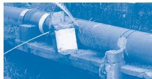
Flagrante de ligações clandestinas em adutora. Evite e denuncie o "gato", ele poderá levar doença para dentro de sua casa.
