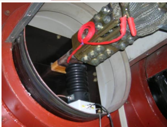
Exemplo de instalação de sensor de DP.
