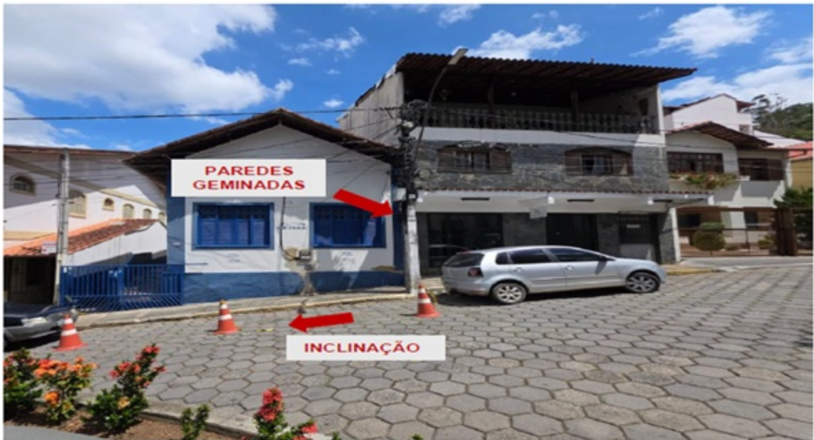
FIGURA 1 – FACHADA DO PRÉDIO
