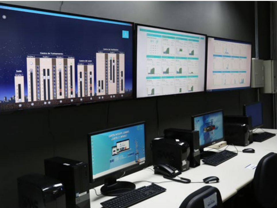
Centro de Controle de Operações: otimização dos processos com uso de tecnologia e geração de economia
