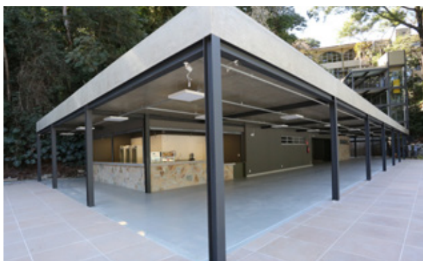
Prédio da lanchonete e dos vestiários
