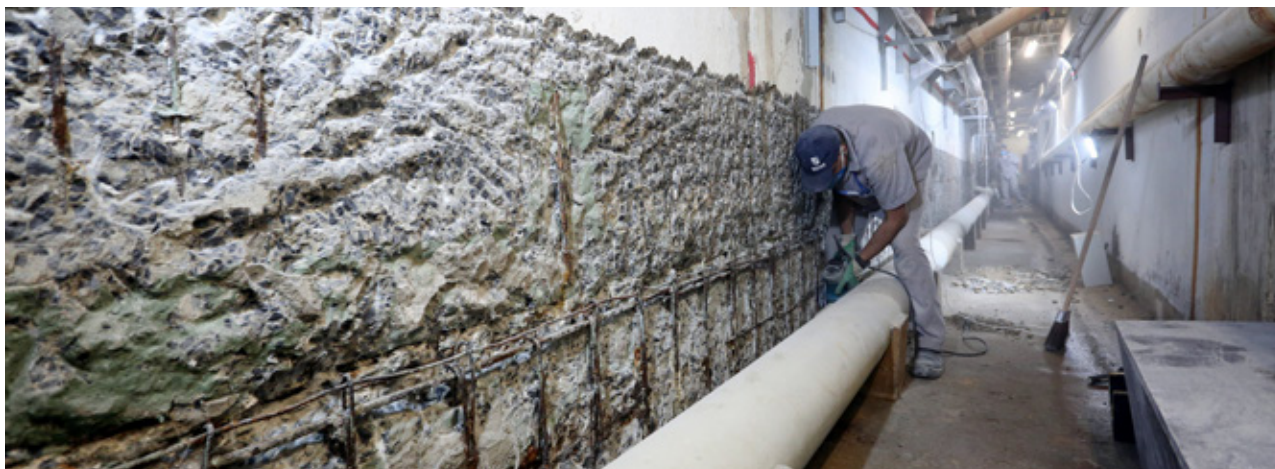
Preparação da parede: limpeza e tratamento da ferragem
