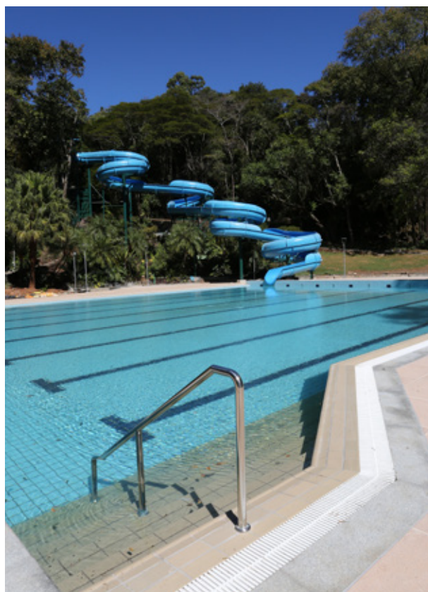
A nova piscina semiolímpica tem escada de acesso para pessoas com mobilidade reduzida
